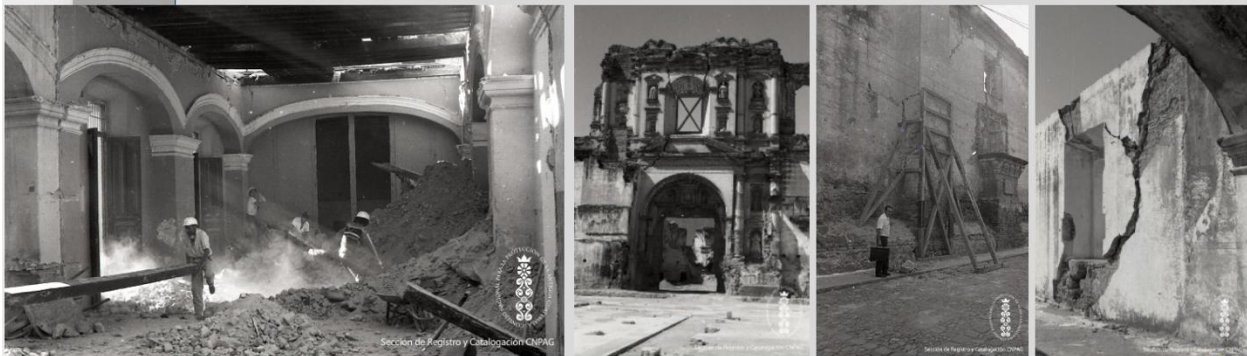
Figure 9: Photographs showing the damage to the church and convent of Compañía Jesús after the 1976 earthquake (Photos courtesy of CNPAG Sección de Registro y Catalogación).
