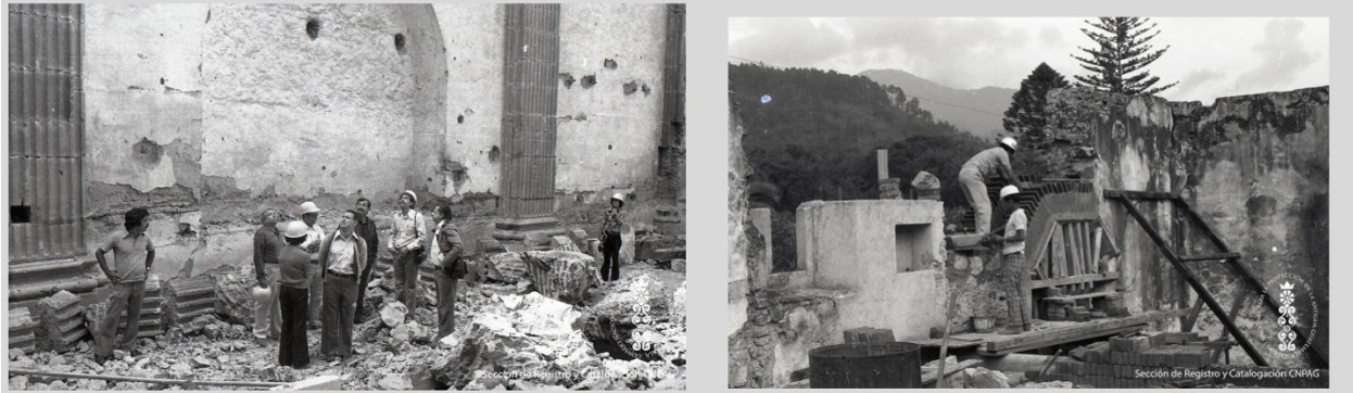
Figure 3: Damage from the 1976 earthquake and repair to the Convento y Iglesia Capuchinas (Courtesy of CNPAG Sección de Registro y Catalogación).
